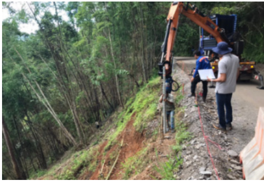
รูปที่ 10 ขณะทำการติดตั้งเสาเข็มสกรู
