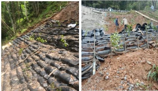
รูปที่ 11 ขณะทำการวางกระสอบแบบมีปีก
