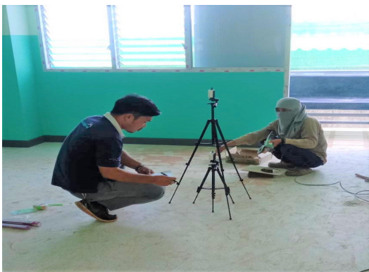
รูปที่ 3 การเก็บข้อมูลในงานก่อสร้างอาคารบ้านพักอาศัย
