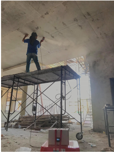
รูปที่ 3 ขั้นตอนการทำงานขัดห้องพื้นฝ้าเพดาน
