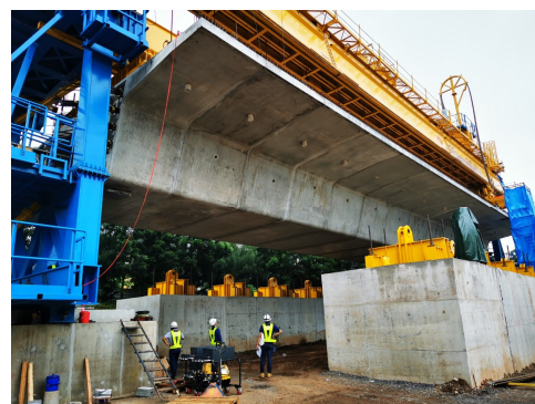
รูปที่ 3 โครงสร้าง Viaduct ที่ใช้ทดสอบ
