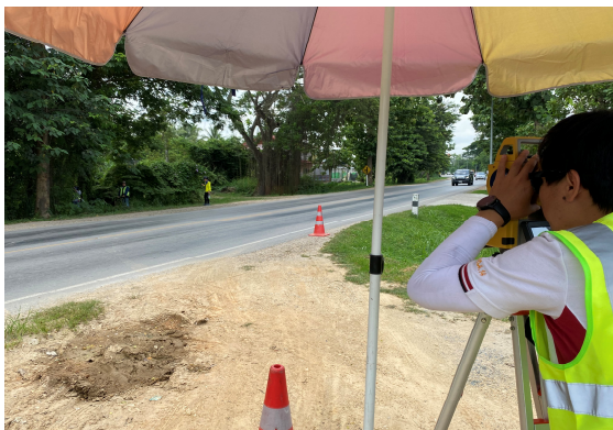
รูปที่ 6 การเก็บพิกัดโดยใช้กล้องโททอลสเตชั่น
