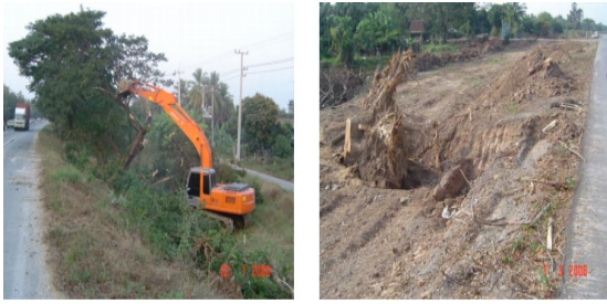
รูปที่ 2 รูปภาพเครื่องจักรเข้าพื้นที่ก่อสร้างเพื่อทำการรื้อถอนต้นไม้ที่ติดขัดการก่อสร้างถนน
