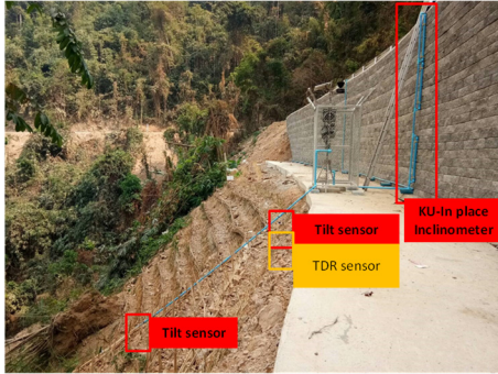
รูปที่ 4 การติดตั้งอุปกรณ์ตรวจวัดในสนามของกำแพงกันดิน เสริมแรงบริเวณทางหลวงชนบท กจ.4088 กม.7+6500
