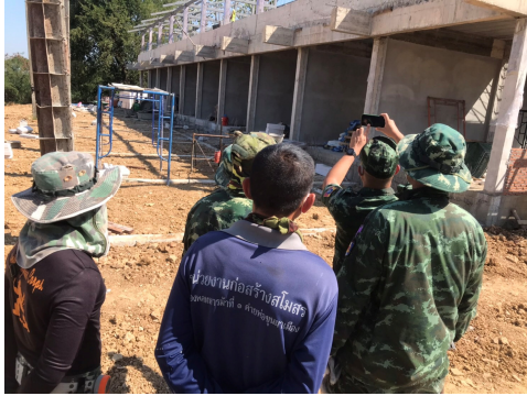
รูปที่ 5 ภาพการใช้งานเทคโนโลยีความจริงเสมือนกับงานก่อสร้างโครงหลังคา
