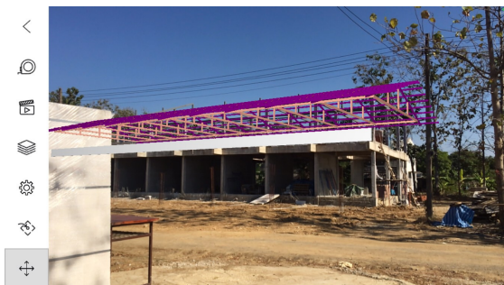
รูปที่ 8 ภาพความจริงเสมือนของโครงหลังคา ซ้อนบนภาพจริงของพื้นที่งานก่อสร้าง
