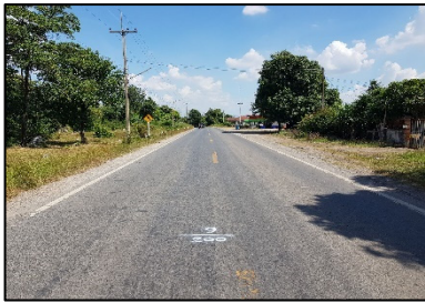
รูปที่ 8 ถนนสาย สป.1002 ก่อนการก่อสร้างถนนทดลอง
