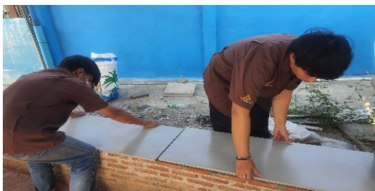
รูปที่ 21 การติดตั้งพื้นม้านั่ง ด้วยผลิตภัณฑ์แผ่นใยไม่อัดซีเมนต์จากเส้นใยทะเลลายปาล์มเปล่า [5]
