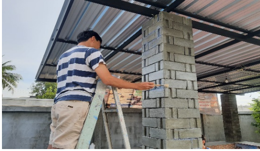
รูปที่ 24 การแก้ไขข้อบกพร่องของเสาอิฐบล็อกประสานจากฝุ่นหินแกรนิต [2]
