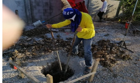
รูปที่ 14 การก่อสร้างฐานรากแผ่
