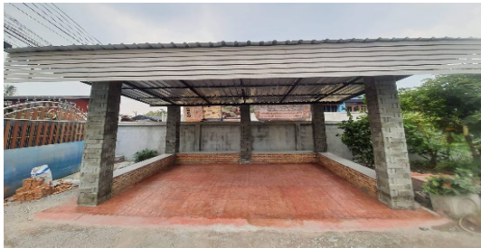
รูปที่ 25 การแก้ไขข้อบกพร่องของผิวพื้นอาคารคอนกรีตพิมพ์ลายจากมอร์ตาร์ฝุ่นหินแกรนิต [4]
