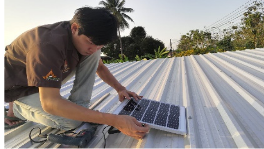
รูปที่ 22 การติดตั้งระบบแสงสว่าง
