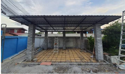
รูปที่ 18 การก่อสร้างพื้นคอนกรีตเสริมเหล็ก
