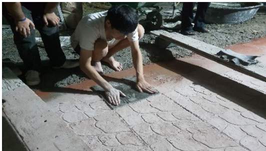
รูปที่ 19 การทำผิวพื้นอาคารจากมอร์ตาร์ฝุ่นหินแกรนิต ด้วยวิธีคอนกรีตพิมพ์ลาย [4]
