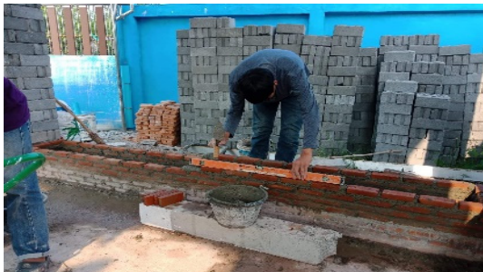
รูปที่ 20 การก่อม้านั่ง ด้วยอิฐมอญดินเหนียวผสมเส้นใย ผักตบชวาแห้งบดละเอียด [2]
