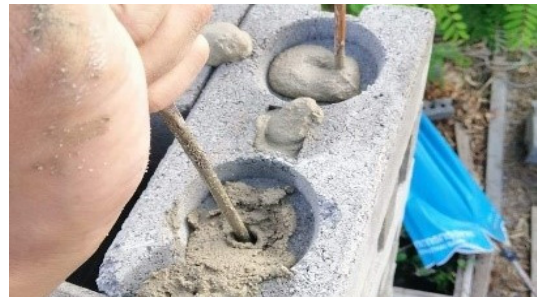
รูปที่ 16 การก่อเสาอิฐบล็อกประสานด้วยมอร์ตาร์ที่ผสมจากฝุ่นหินแกรนิต [1]
