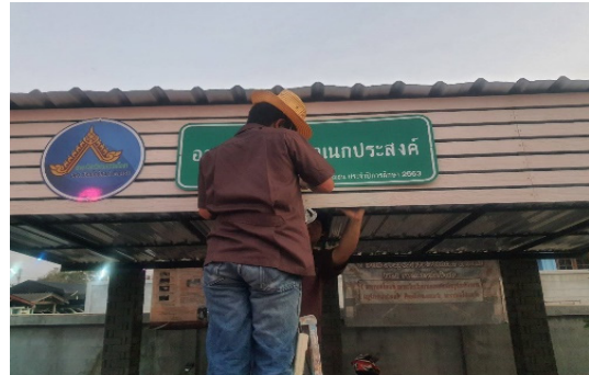
รูปที่ 23 การติดตั้งป้ายชื่ออาคาร
