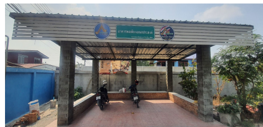
รูปที่ 26 ลักษณะของอาคารพวยงเนกประสงค์ที่แล้วเสร็จสมบูรณ์
