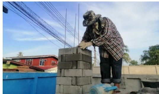
รูปที่ 15 การก่อสร้างเสา ด้วยผลิตภัณฑ์อิฐบล็อกประสานจากฝุ่นหินแกรนิต [3]
