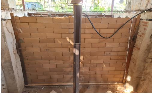
รูปที่ 3.4 ทดสอบกำแพงกันดินเสริมแรง GFRP
