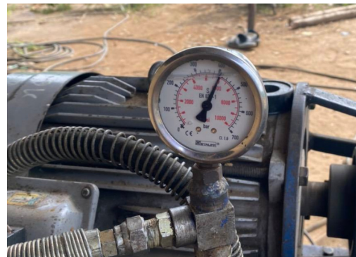
รูปที่ 19 มาตรวัดความดันไฮดรอลิกสำหรับทดสอบกำลังรับน้ำหนักของเสาเข็ม
