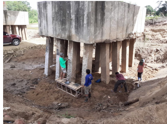
รูปที่ 9 การเตรียมพื้นที่ก่อนการก่อสร้าง
