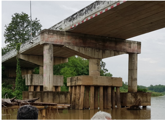
รูปที่ 5 การซ่อมแซมฐานรากสะพานด้วยวิธีโครงเฟรม
