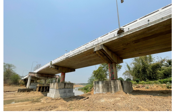
รูปที่ 17 สะพานที่ถูกเสริมกำลังฐานรากเรียบร้อยแล้ว
