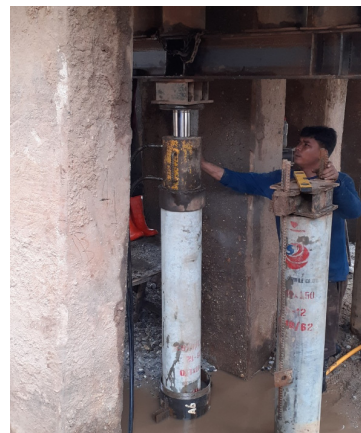
รูปที่ 13 การกดเสาเข็มลงดินด้วยแม่แรงไฮดรอลิก
