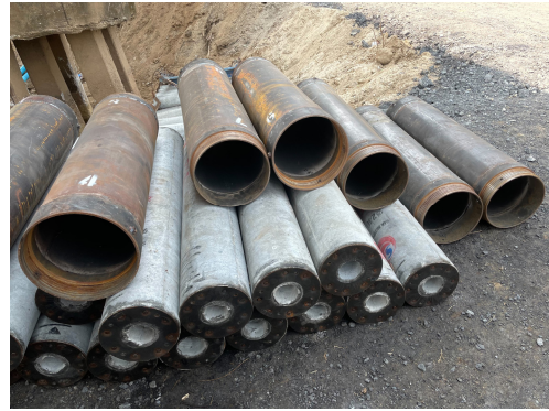
รูปที่ 12 ปลอกเหล็กชั่วคราว และเสาเข็มสปันไมโครไพล์
