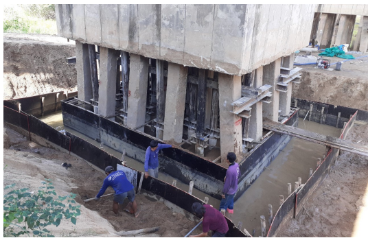
รูปที่ 15 ขั้นตอนการหล่อฐานรากใหม่
