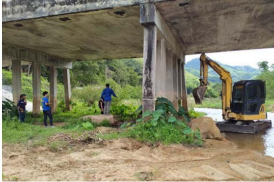
รูปที่ 7 การเตรียมพื้นที่ก่อนการก่อสร้าง
