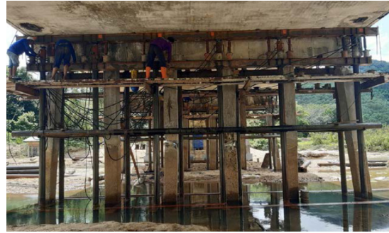
รูปที่ 14 การยกปรับระดับสะพานด้วยแม่แรงไฮดรอลิค
