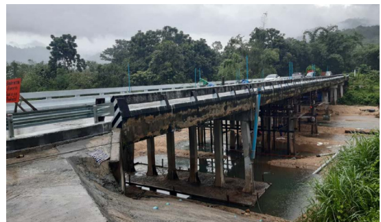
รูปที่ 16 สะพานหลังการซ่อมแซมสำเร็จ
