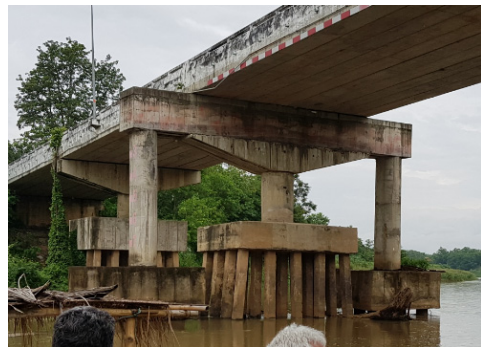
รูปที่ 3 การซ่อมแซมฐานรากสะพานด้วยวิธีโครงเฟรม
