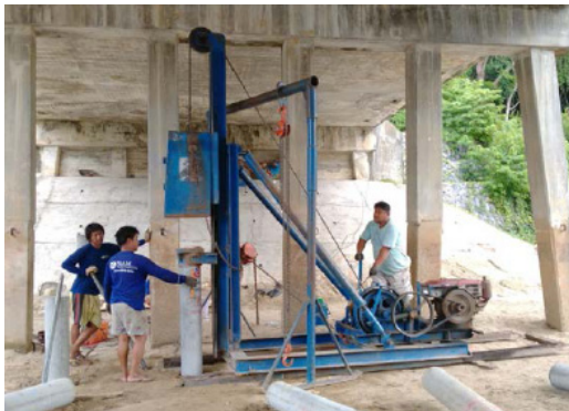
รูปที่ 12 ภาพการตอกเสาเข็มสปีนไมโครโพล์
