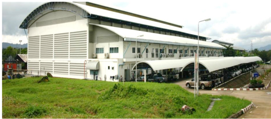
รูปที่ 1 อาคารโรงงานที่เกิดปัญหา
