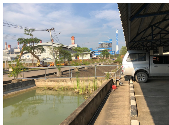
รูปที่ 16 น้ำในคูระบายน้ำ
