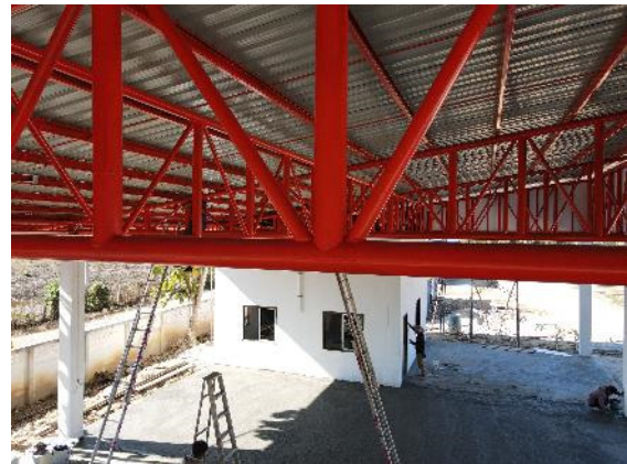
รูปที่ 13 แสดงภาพถ่ายรอยเชื่อมต่อของโครงถัก ในมุม 0 องศา
