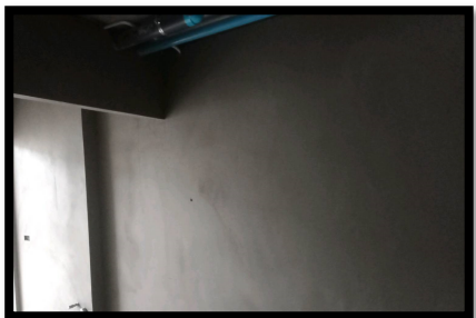
รูปที่ 3 โครงการฉาบผนังฉาบปูน
