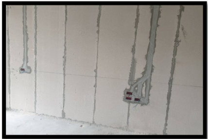
รูปที่ 2 โครงการฉาบผนังแผ่นมวลเบา
