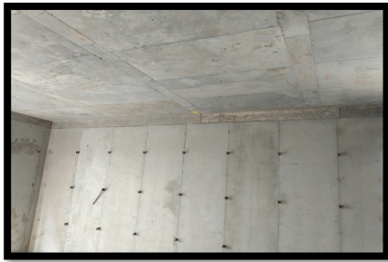
รูปที่ 1 โครงการฉาบผนังโครงการสร้างคอนกรีตเสริมเหล็ก
