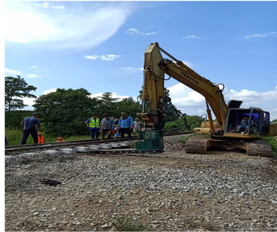
รูปที่ 9 การปาดหินด้วย Ballast blaster undercutter
