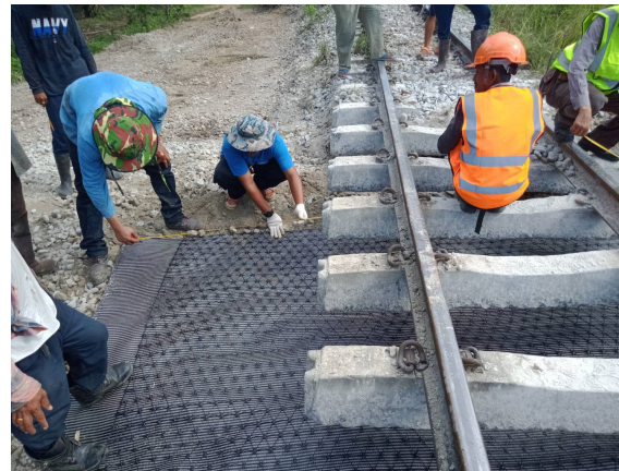
รูปที่ 10 การติดตั้งแผ่นใยสังเคราะห์ตาข่ายเสริมกำลังดินและหินโรยทาง
