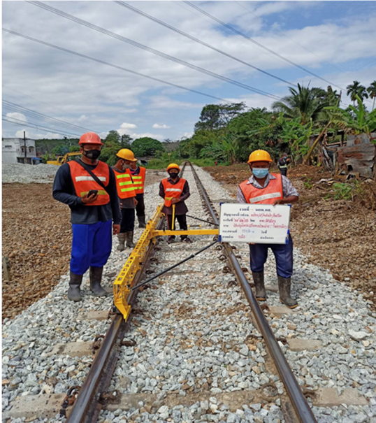
รูปที่ 12 ตรวจสอบมิติทางเรขาคณิตด้วยเครื่องวัดสภาพทาง
