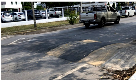
รูปที่ 4 เนินชะลอความเร็วภายในนิคมอุตสาหกรรมลาดกระบัง
