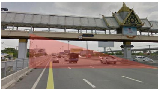
รูปที่ 1 การติดตั้งเซ็นเซอร์ชุดตรวจวัดความเร็วเป็นแบบชนิดที่ใช้คลื่นความถี่ไมโครเวฟ (Microwave)
