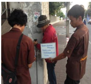
รูปที่ 1 การทดสอบวัดระยะคอนกรีตหุ้มเหล็กเสริม
