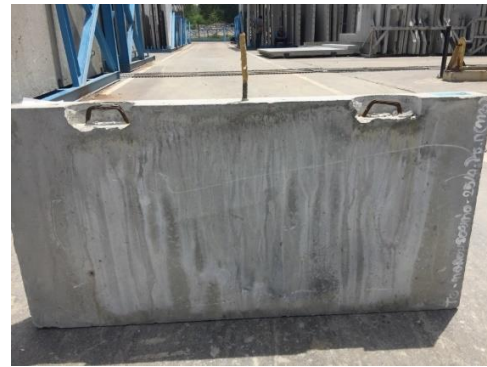
รูปที่ 3 ตัวอย่างจุดเชื่อมต่อแบบ Dowel Connection โดยฝังเหล็ก 1-DB12
