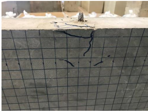
รูปที่ 13 การวิบัติของ Dowel connection ระยะเวลาฝัง 30 cm
