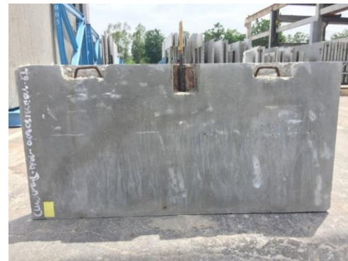
รูปที่ 4 ตัวอย่างจุดเชื่อมต่อแบบ Plate Connection โดยฝังแผ่นเหล็กเชื่อมกับเหล็กหนวดกุ้ง 2-DB12
