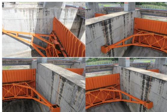
รูปที่ 3 ประตูระบายน้ำล้น(spillway radial gate)
