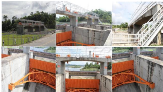
รูปที่ 2 อาคารระบายน้ำล้นเขื่อนกักคอกหมา
