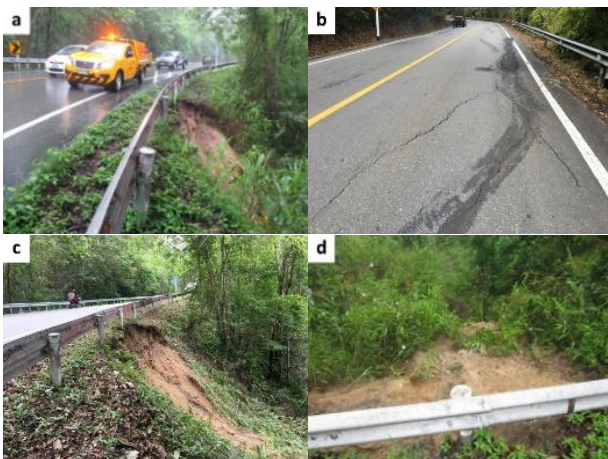
รูปที่ 1 แสดงการพังทลายของลาดดิน (a)การสัญจรบริเวณดังกล่าว,(b)รอยแตกของถนน, (c)การพังทลายของลาดดิน, (d)การกัดเซาะของน้ำ
