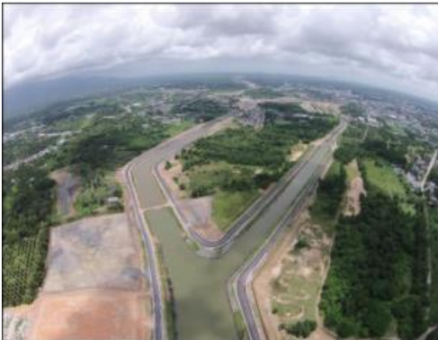
รูปที่ 3 คลองผันน้ำกักตุนน้ำของโครงการบรรเทาอุทกภัยจังหวัดจันทบุรี [2] (ต่อ)
