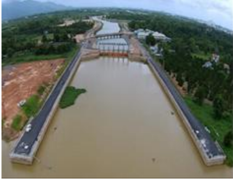
รูปที่ 3 คลองผันน้ำกักตุนน้ำของโครงการบรรเทาอุทกภัยจังหวัดจันทบุรี [2]
