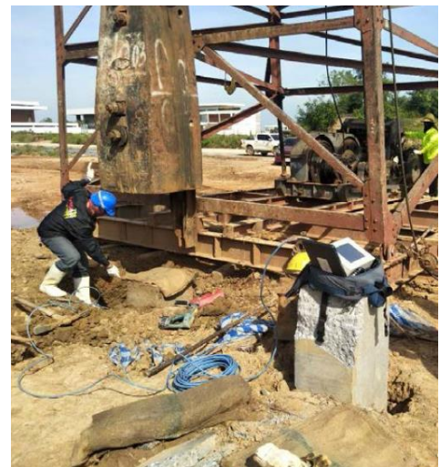
รูปที่ 4 การทดสอบกำลังรับน้ำหนักบรรทุกทุกของเสาเข็มแบบพลศาสตร์
