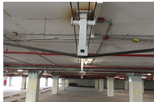
รูปที่ 11 การเสริมกำลังด้วยวิธี EPT
