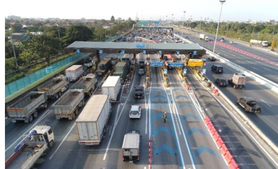
รูปที่ 4 รถบรรทุกมีสภาพการจราจรสภาวะอิ่มตัว บริเวณหน้าด่านฯ
