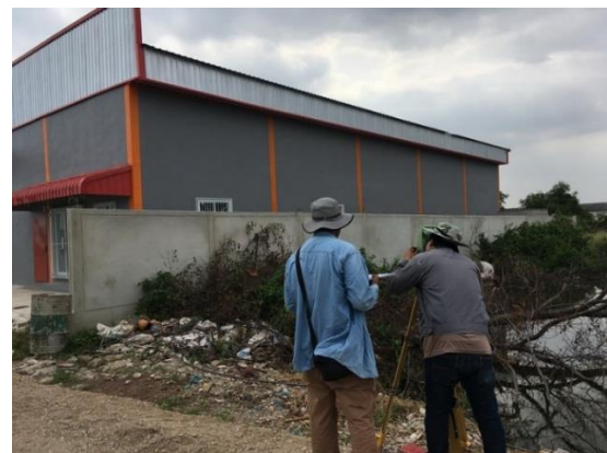
รูปที่ 10 การรังวัดค่าพิกัดของมุมอาคารด้วยกล้อง Total Station
