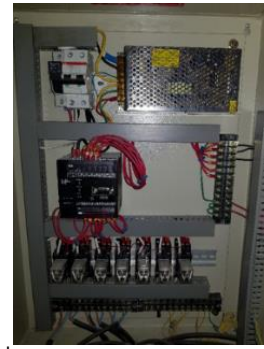
รูปที่ 3 ระบบควบคุมการทำงานด้วยพีแอลซี
