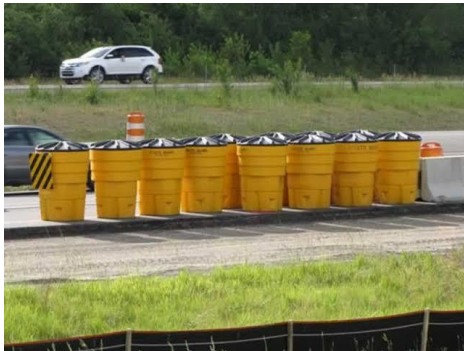
รูปที่ 8 Sand Barrel Cushion
