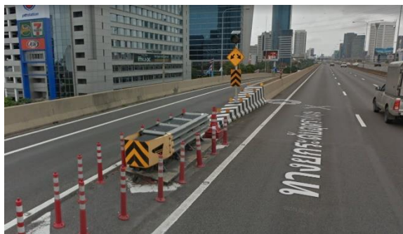
รูปที่ 2 Crash Cushion บริเวณหัวเกาะทางลง
