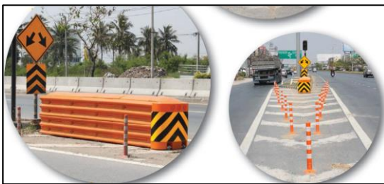
รูปที่ 5 การติดตั้ง Crash Cushion ทางหลวงชนบท
