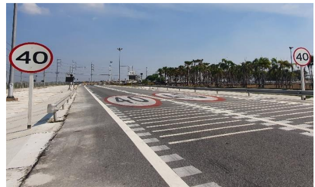
ก) การติดตั้งป้ายจำกัดความเร็ว การตีเส้น Rumble Strip และ Optical Speed Bar ในช่วงก่อนเข้าทางโค้ง
