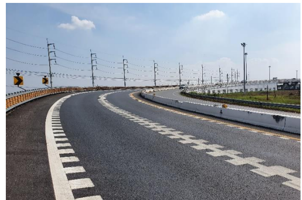
ข) การตีเส้น Optical Speed Bar และจัดช่องจราจรใหม่ในช่วงทางโค้ง
