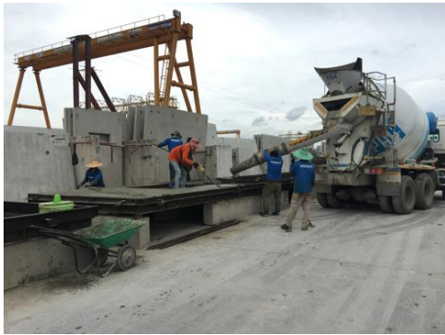
รูปที่ 3 ภาพแรงงานขณะเทคอนกรีต
