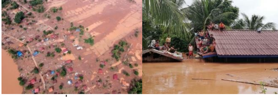
รูปที่ 8 ความเสียหายจาก Saddle Dam D วิบัติ
