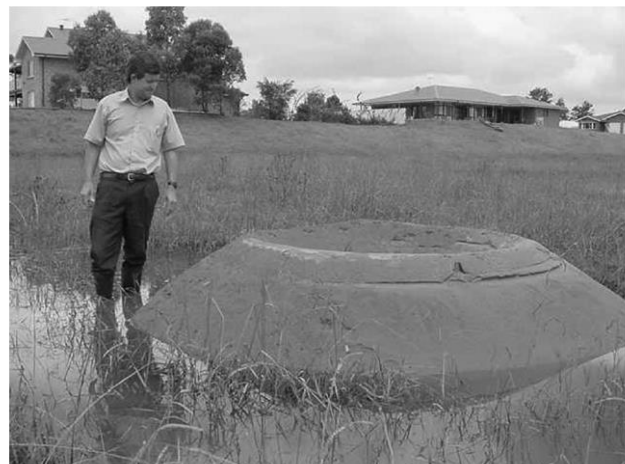
รูปที่ 4 Sand Boil ที่เกิดขึ้นบริเวณด้านท้ายน้ำของพังกันน้ำ
