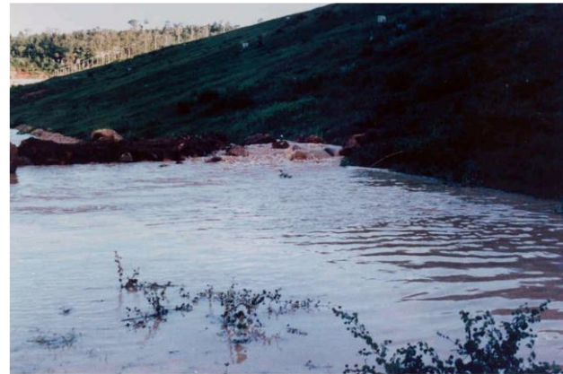
รูปที่ 2 - จุดรั่วที่ 1 - Sta. 0+856 ระดับที่ไหลออกจากรูรั่วสูงกว่าระดับหลังของ Rockfill Toe - วันที่ 24 ตุลาคม 2533
