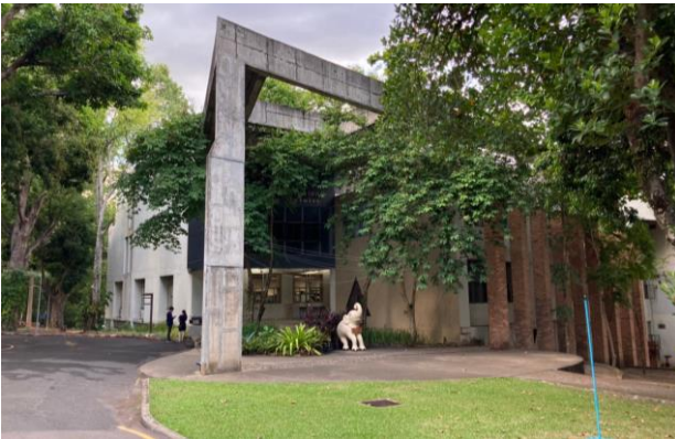
รูปที่ 10 สภาพสถานที่ รอบอาคาร
