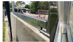
รูปที่ 11 การยึดติดตั้งเหล็กทรงฐานกับเสาเหล็กรูปพรรณ
