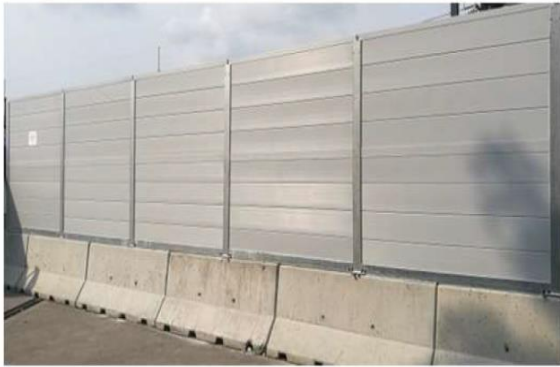
รูปที่ 1 ต้นแบบกำแพงกันเสียงชนิดสะท้อนเสียง
