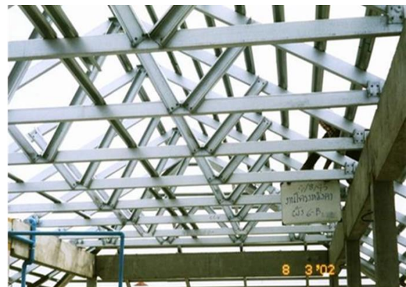
รูปที่ 4 วัสดุโครงสร้างหลังคา
