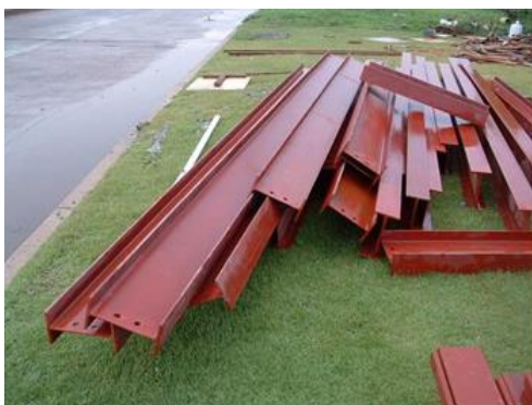
รูปที่ 3 สถานที่เก็บวัสดุในโครงการก่อสร้าง
