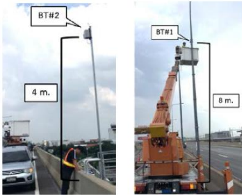
รูปที่ 5 ตำแหน่งติดตั้งเครื่องตรวจจับสัญญาณบลูทูธ (ซ้าย) จุดต้นทาง (ขวา) จุดปลายทาง
