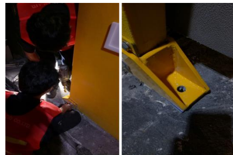
รูปที่ 16 การเจาะรูแผ่นพื้นคอนกรีตเพื่อใส่สลักเกลียวยึดติดฐานต้นแบบตู้เก็บค่าผ่านทางฯ (รูปแบบ B)
