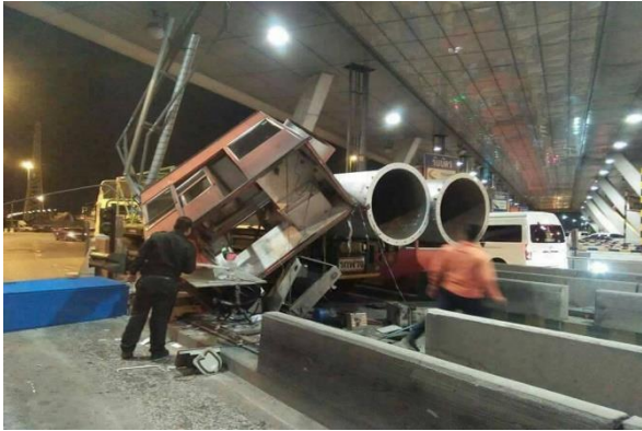
รูปที่ 1 อุบัติเหตุการเฉี่ยวชนตู้เก็บค่าผ่านทางฯ จากรถบรรทุกขนาดใหญ่
