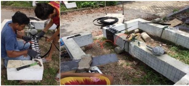
รูปที่ 2 การเสริมกำลังคานด้วยแผ่นเหล็กเหนียว (คาน B2-ST)
