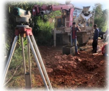
(ง) เทคอนกรีตเสาเข็ม
