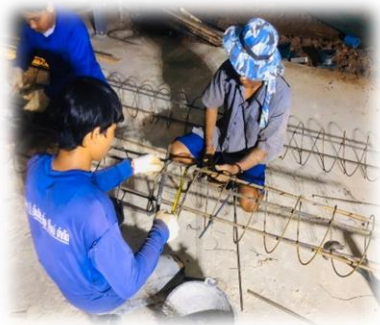
(ก) มัดเหล็กเสริม
