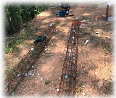
(ข) ติดตั้งอุปกรณ์วัดความเครียดพร้อมเดินสายไฟ
