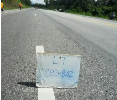
รูปที่ 6 ความเสียหายของผิวทางแบบร่องล้อ
