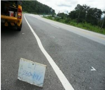
รูปที่ 5 ความเสียหายของผิวทางแบบรอยปูดนูน
