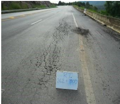
รูปที่ 4 ความเสียหายของผิวทางแบบรอยแตกหนึ่งจระเข้
