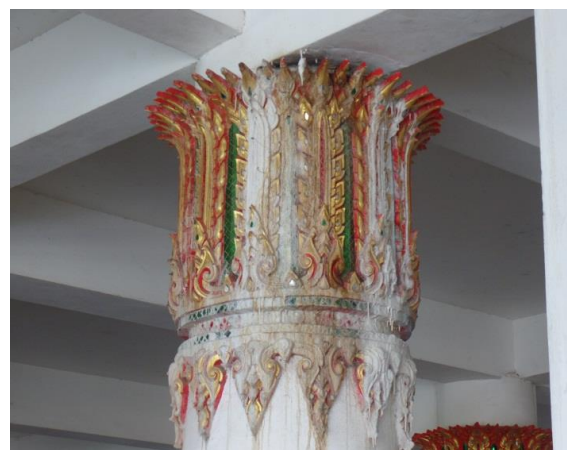
รูปที่ 5 คราบหินปูนบริเวณปูนปั้นของเสา
