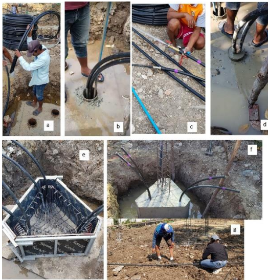
รูปที่ 5 การติดตั้งท่อ HDPE ในเสาเข็มพลังงานไมโครไพล์
