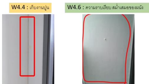
รูปที่ 4 ตัวอย่างลักษณะข้อบกพร่อง W4.4 และ W4.6
